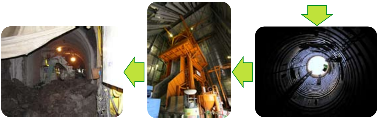
深さ100m 予備ステージ貫通 (平成17年6月)
